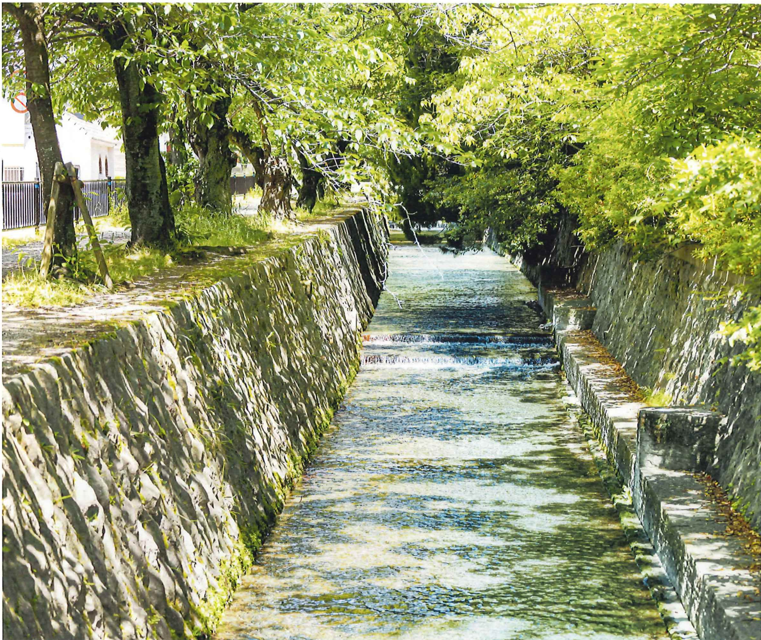
中新田川(徒歩1分(約10m~約20m)、令和6年5月撮影※一部CG加工処理を施しています)
